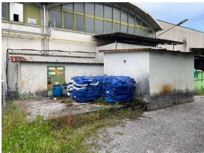
VISTA ESTERNA FABBRICATO
