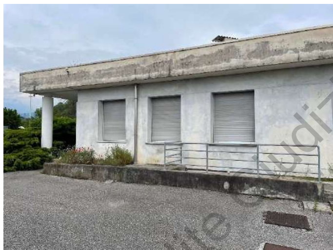
VISTA ESTERNA FABBRICATO
