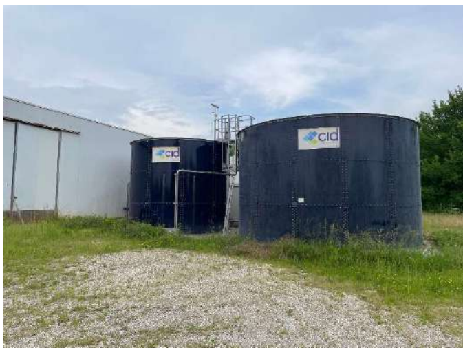
VISTA ESTERNA FABBRICATO
