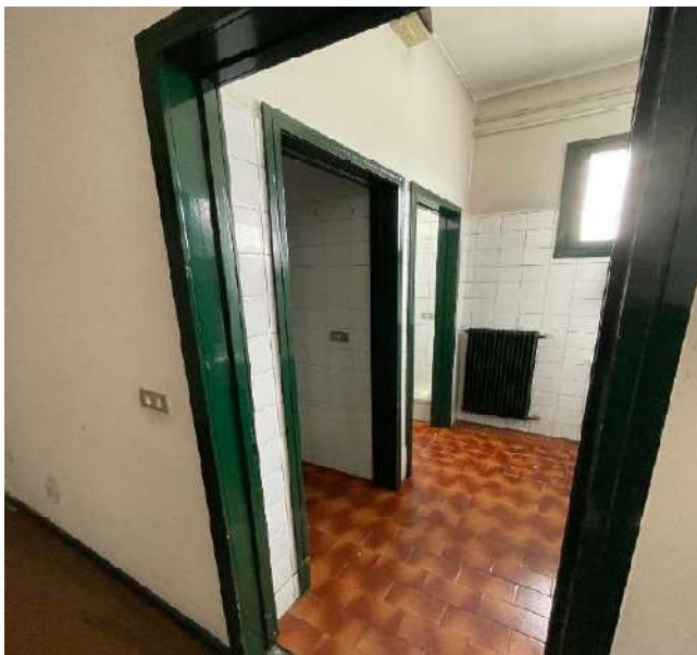
VISTA ZONA SERVIZI/SPOGLIATOI
