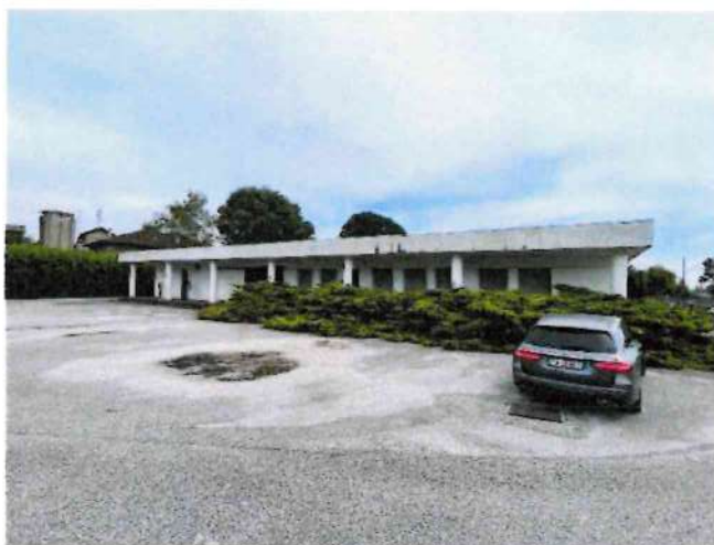
VISTA ESTERNA FABBRICATO
