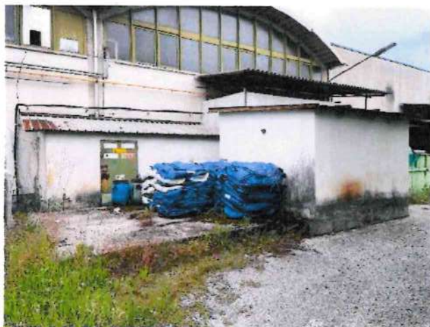
VISTA ESTERNA FABBRICATO
