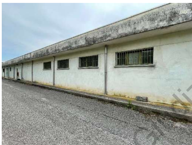
VISTA ESTERNA FABBRICATO
